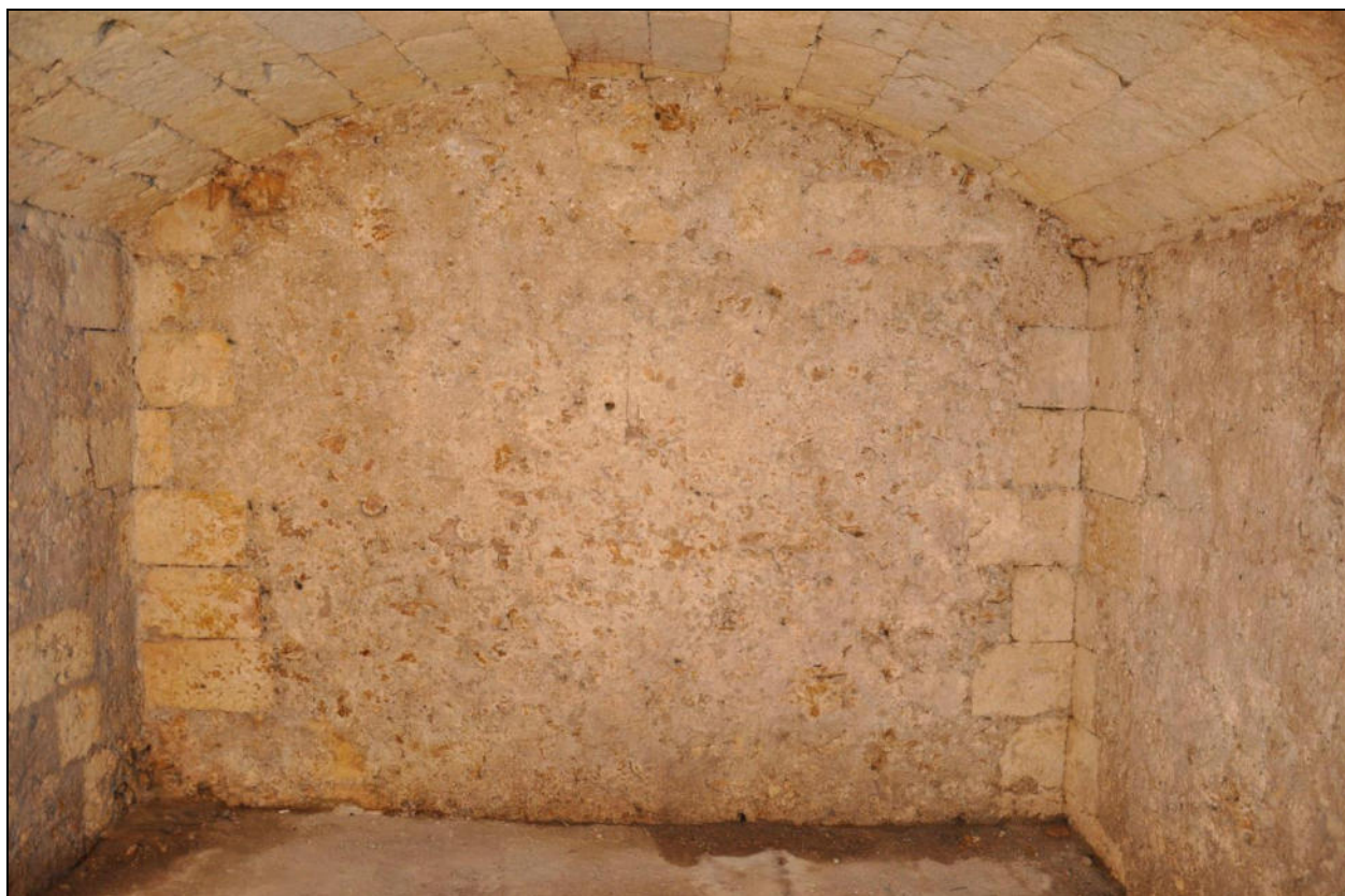
Fig. 24 – Un'altra piccola stanza, a cui si accede lateralmente dall'ampio vano centrale, adibita a diversi usi. La parete frontale, formata ai bordi esterni da conci tufacei e centralmente da un'unica colata di materiale a diversa pezzatura, interrompe la prosecuzione di una probabile galleria (Foto: Schirinzi).
