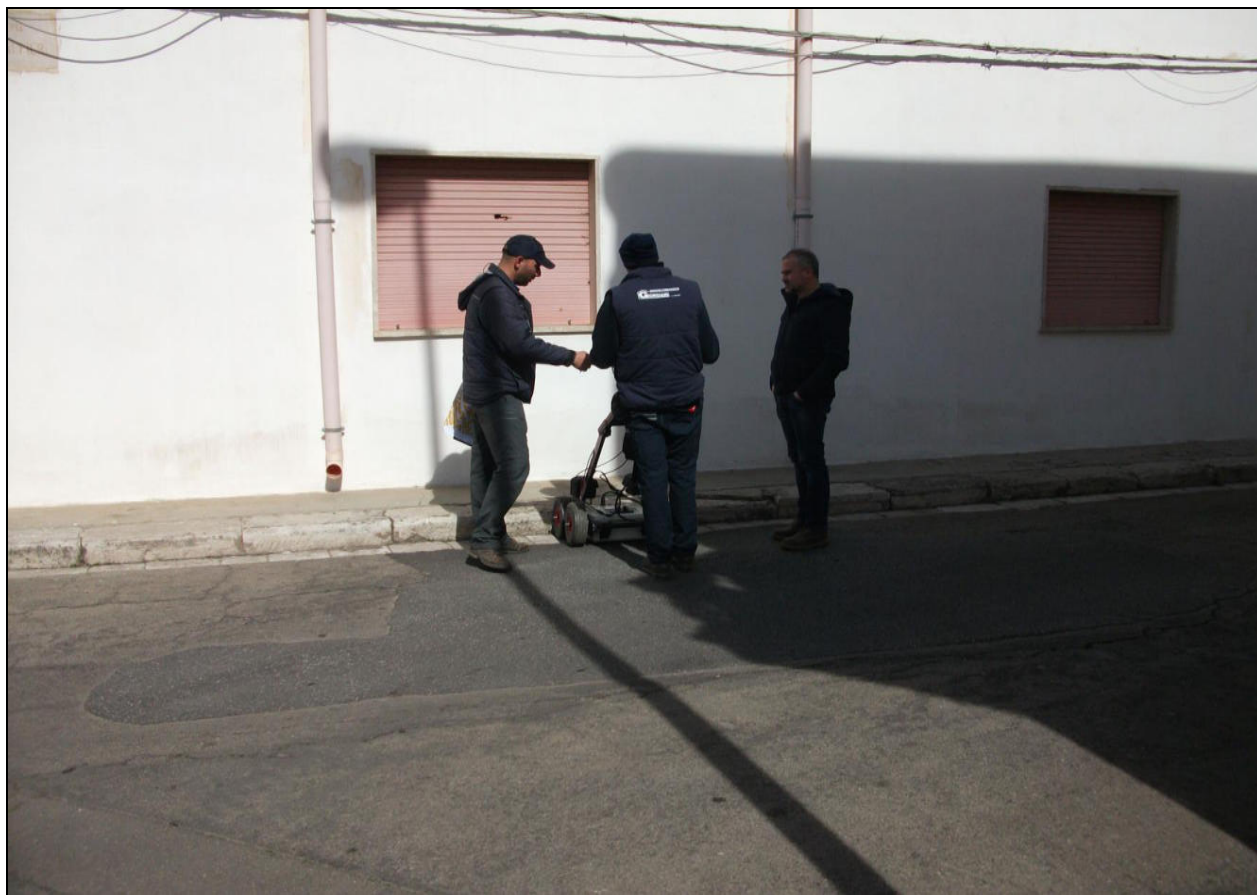
Fig. 18 – Segni di cedimento di un tratto di asfalto di via V. Alfieri.
