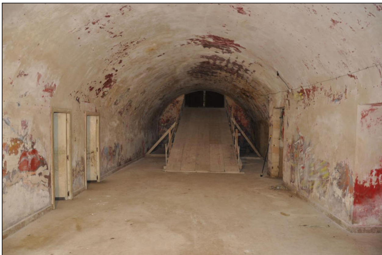
Fig. 26 – Vista, dall'interno verso la rampa, dell'ampio vano, un tempo adibito a discoteca. Sulla parete sinistra si osservano le porte di ingresso a bagni privati (Foto: Schirinzi).
