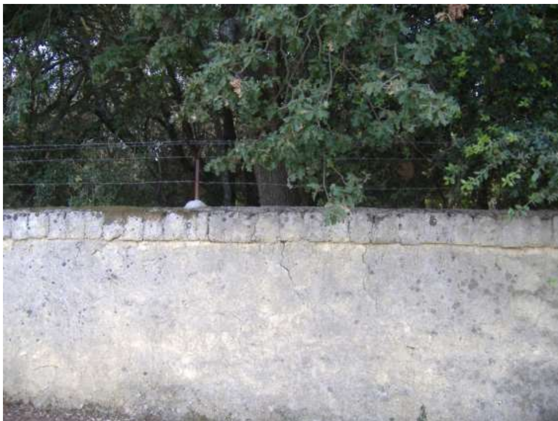
Figura 4 - Particolare del muro perimetrale
